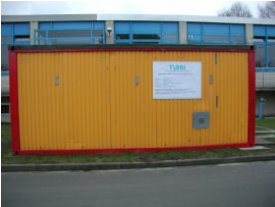
Abb. 1: Pilotanlage von außen
