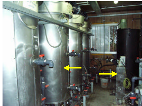
Abb. 2: Pilotanlage von innen; links: Fermenter, rechts: Hochleistungs-Ultraschallreaktor
