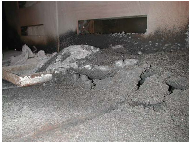
Bild 9: Ablagerungen auf dem Brennkammerboden nach dem Auskühlen der Versuchsanlage (Rückstände Acrylverbrennung)
